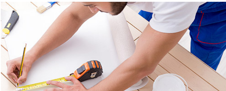
Строительные работы и ремонт помещений
